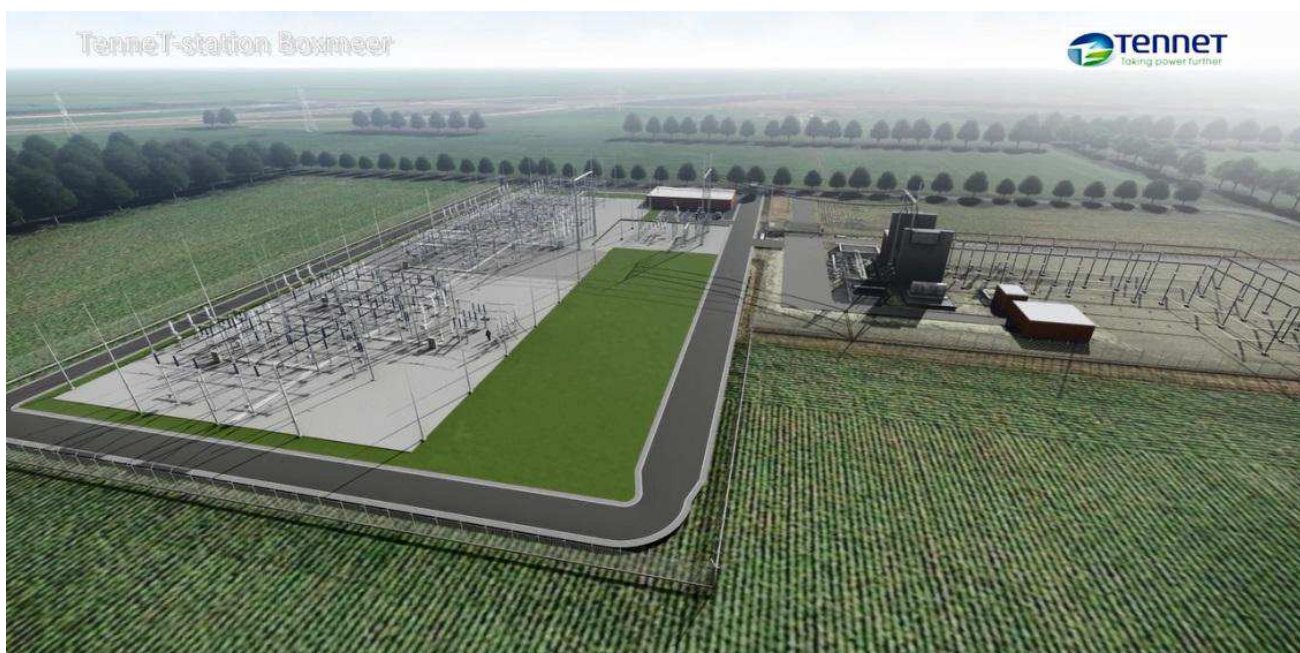
Figuur 6: Toekomstige situatie 150 kV-station Boxmeer
